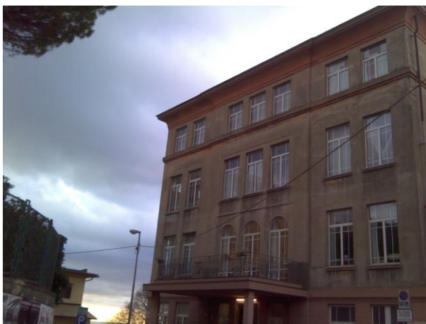
Figura 1: Muratura esterna Est
