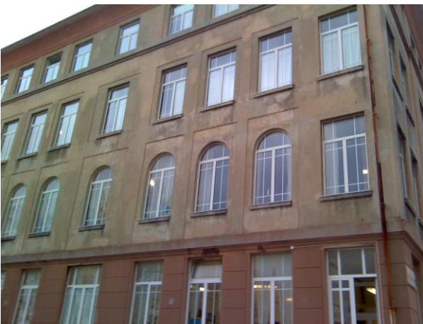
Figura 5: Muratura esterna Sud
