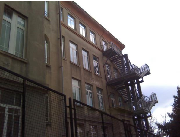
Figura 3: Muratura esterna Nord
